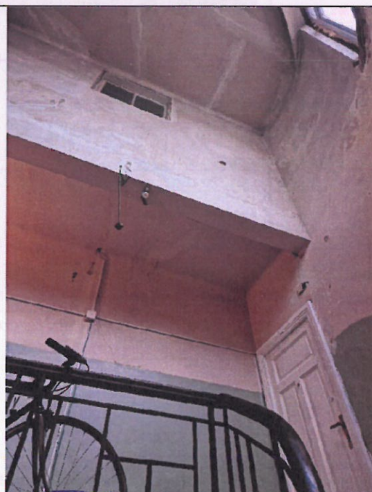
Fig. 11 + Fig. 12. Injectare fisuri peste casa scării. În rest nu s-au observat fisuri pe pereții casei scării
