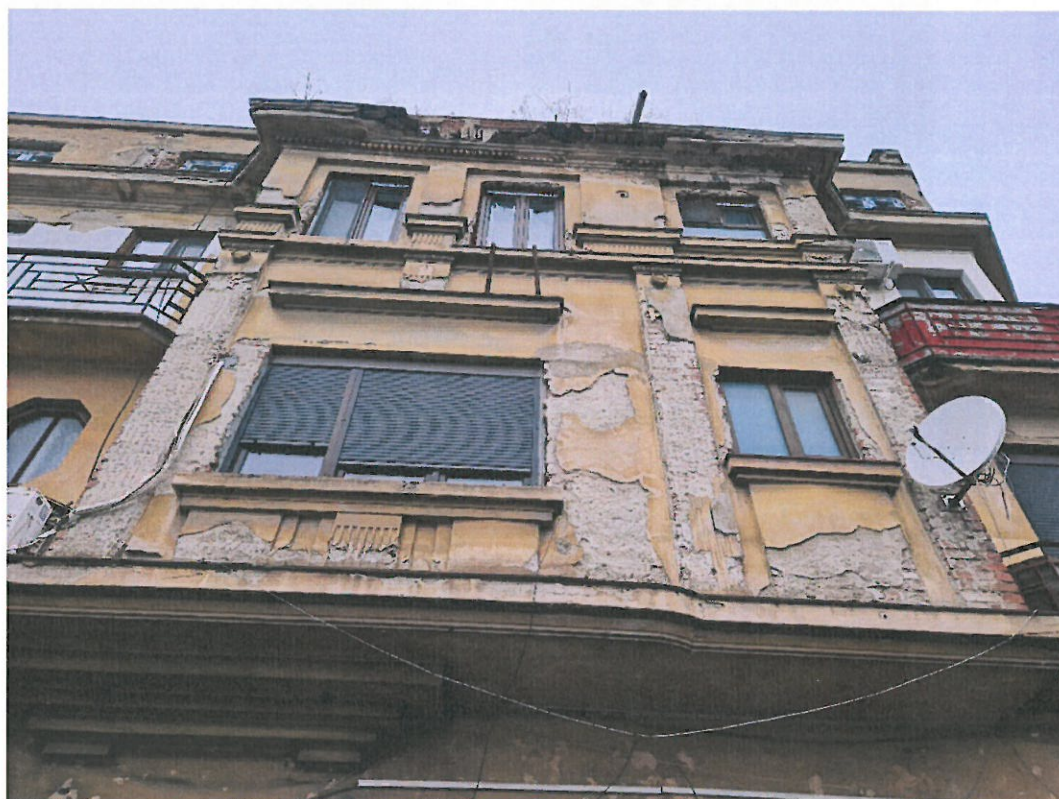
Fig. 5. Fațadă principală – tencuială desprinsă sau degradată
