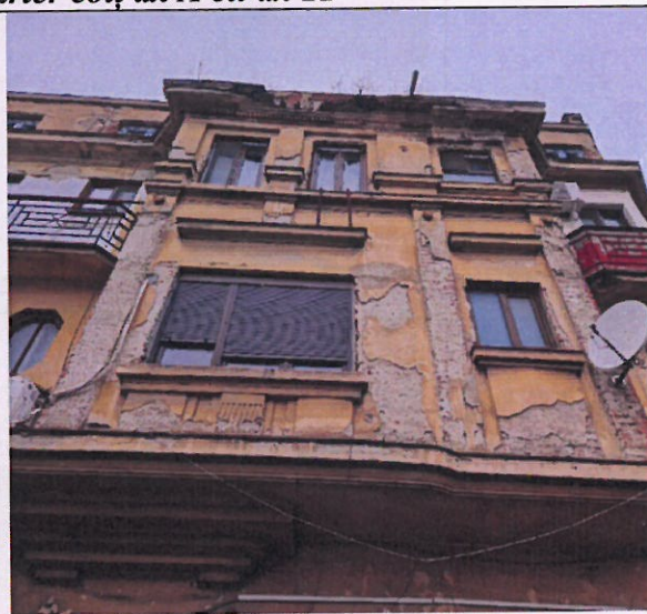
Fig. 4. Fațadă principală – tencuială desprinsă
