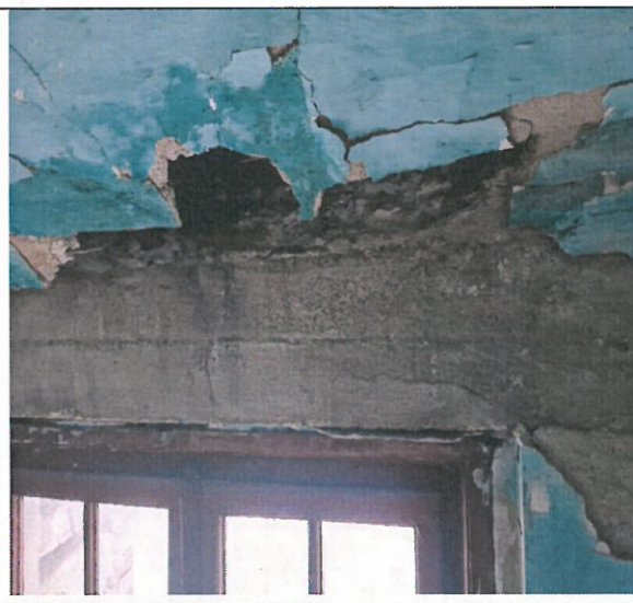
Fig. 14. Planșeu peste mansardă degradat
