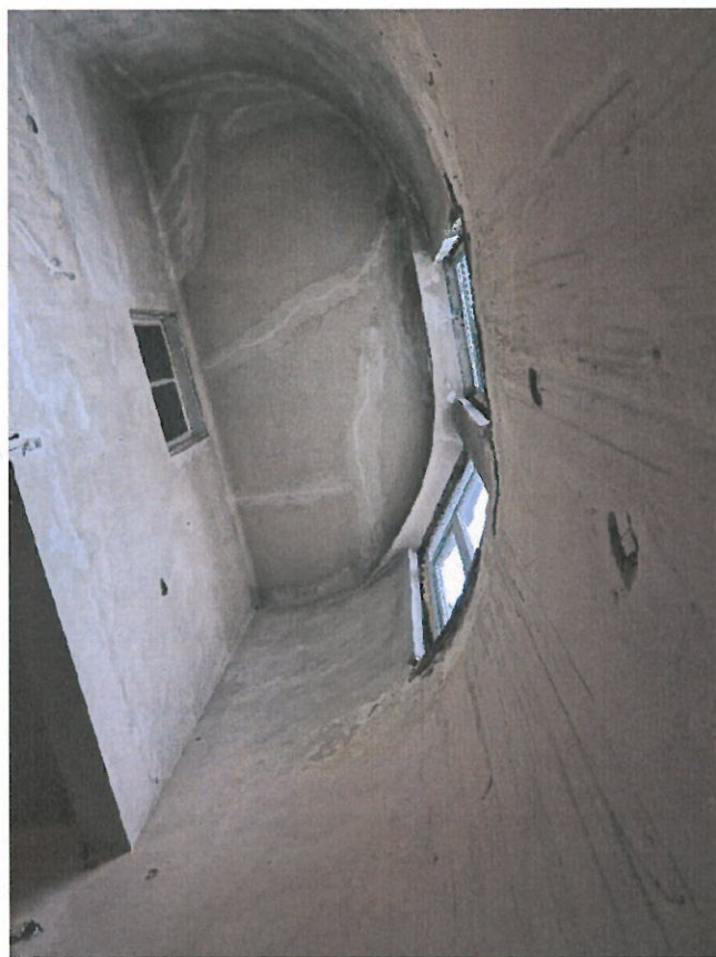
Fig. 13. Fisuri injectate în placa de peste casa scării principale
