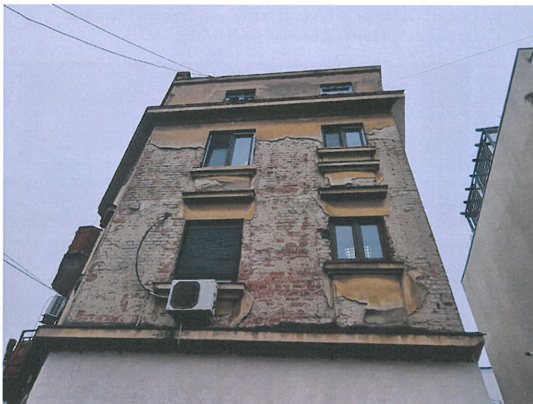
Fig. 4. Fațadă ax 11 – tencuială desprinsă
