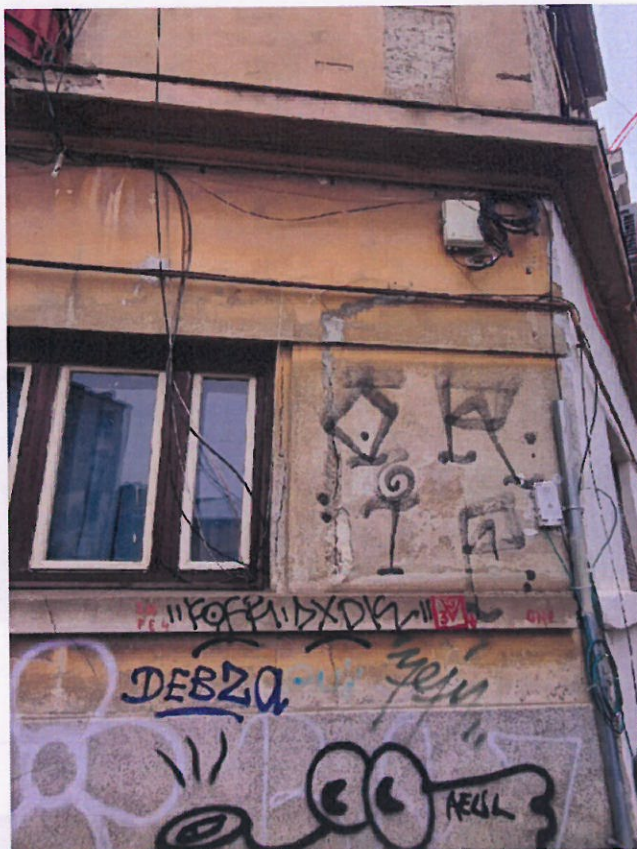
Fig. 2 Fisură verticală perete parter colț ax A cu ax 11
