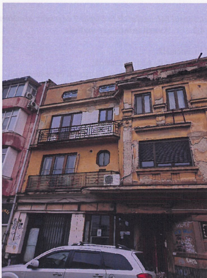
Fig. 6. Fațada principală – tencuieli degradate, streșină căzută pe arii extinse.
