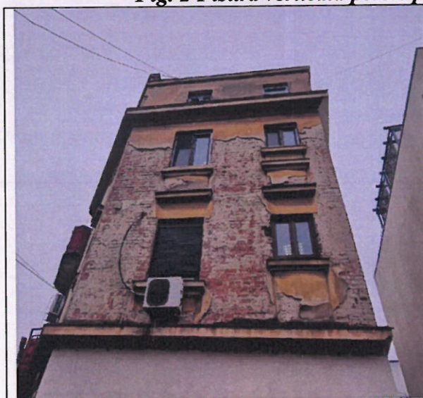
Fig. 3 Fațadă ax 11 – tencuială desprinsă
