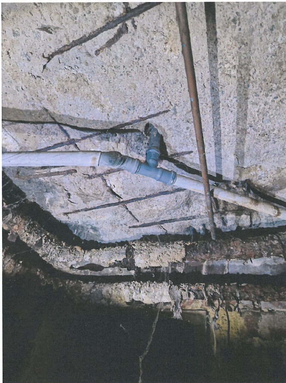
Fig. 10. Armături dezvelite și ruginite la placa de peste subsol – se întâlnesc doar în zonele în care sunt goluri de instalații (3-4 locuri). În general betonul plăcii de peste subsol arată foarte bine
