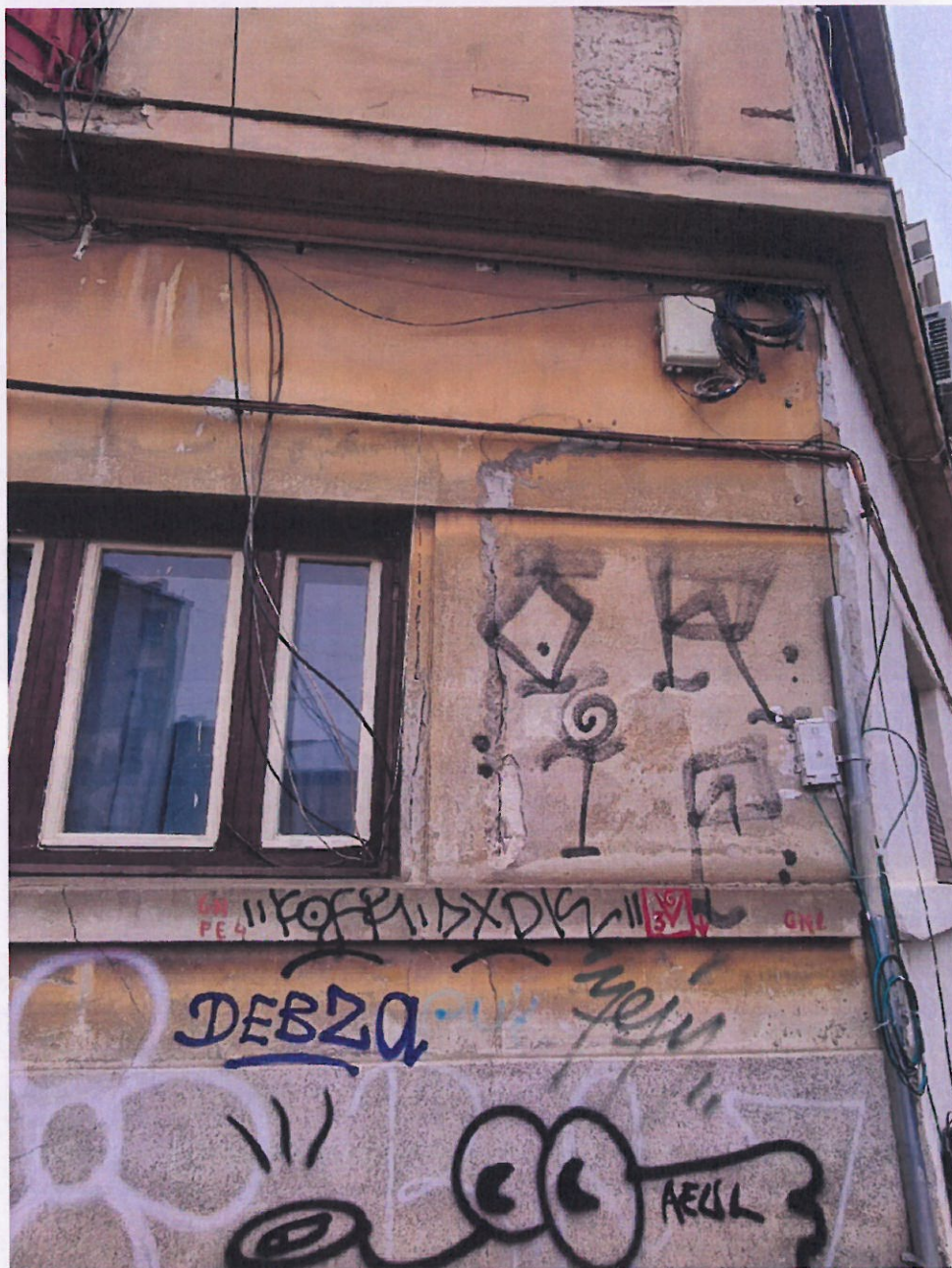
Fig. 3. Fisură verticală montant sidărie
