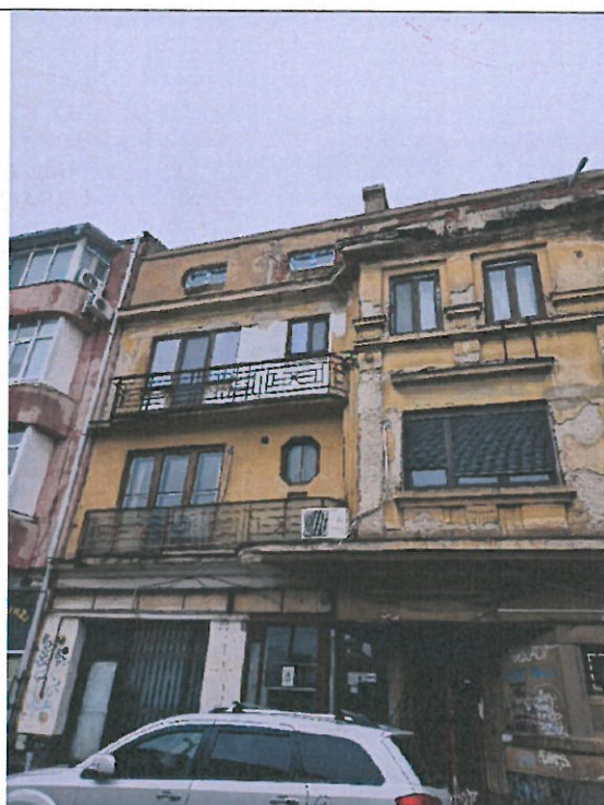
Fig. 5. Fațadă principală – tencuieli degradate, streșină căzută
